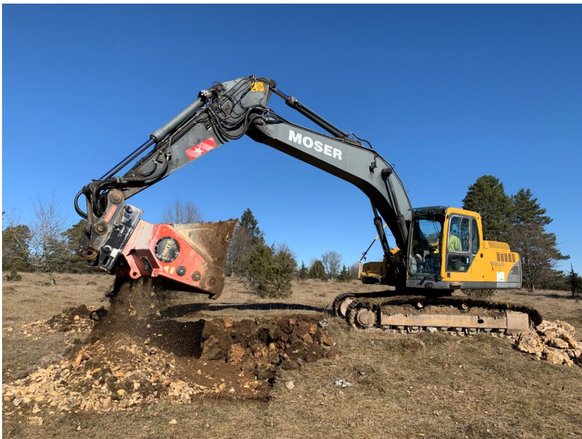
Abbildung 10: Einsatz von schwerem Gerät zur Revitalisierung der Lesesteinhäufen im Naturschutzgebiet Kraftstein
